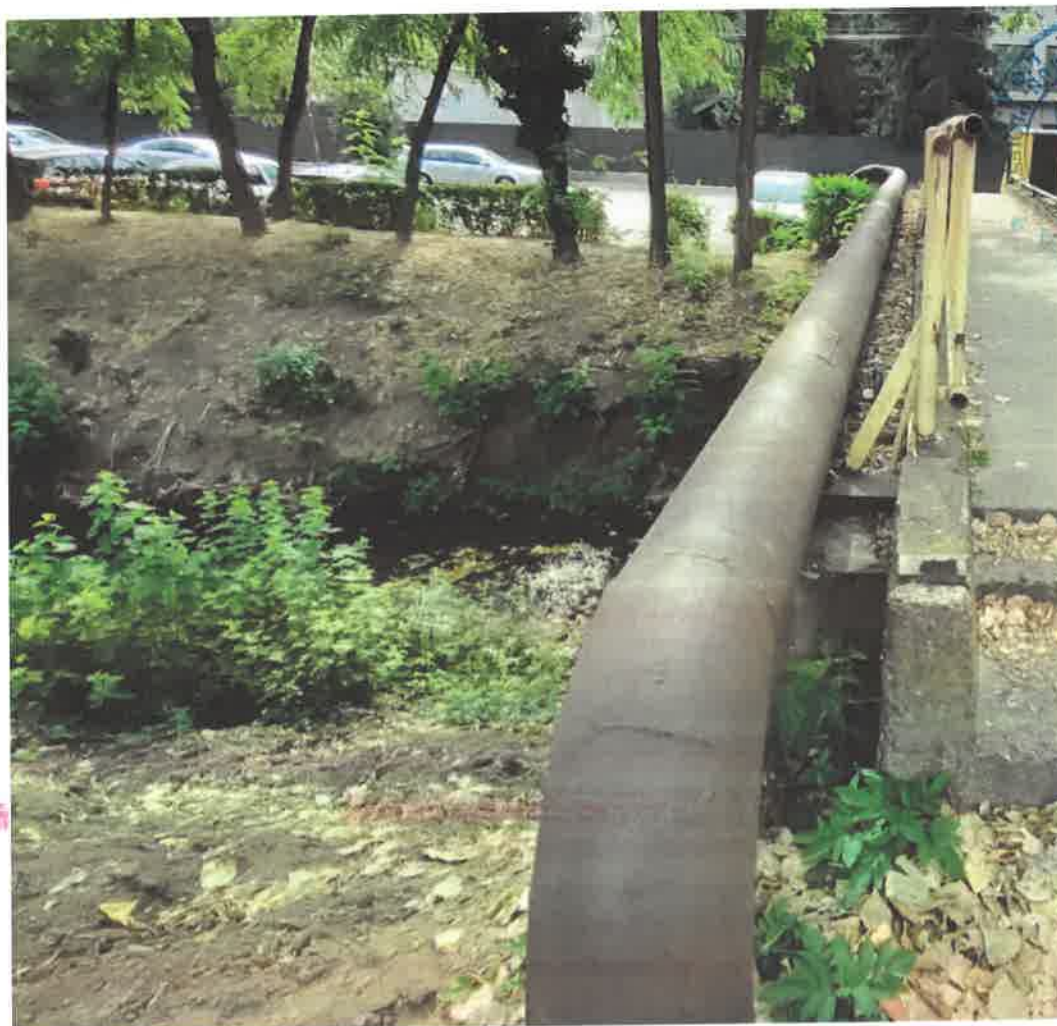
Foto 25, 26, 27: Vedere conducte utilitati ancorate pe pasarela in aval
