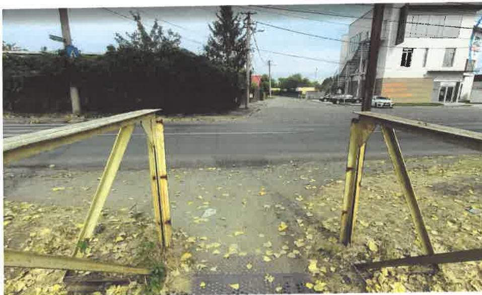
Foto 16: Vedere rampa dinspre Strada Apelor
