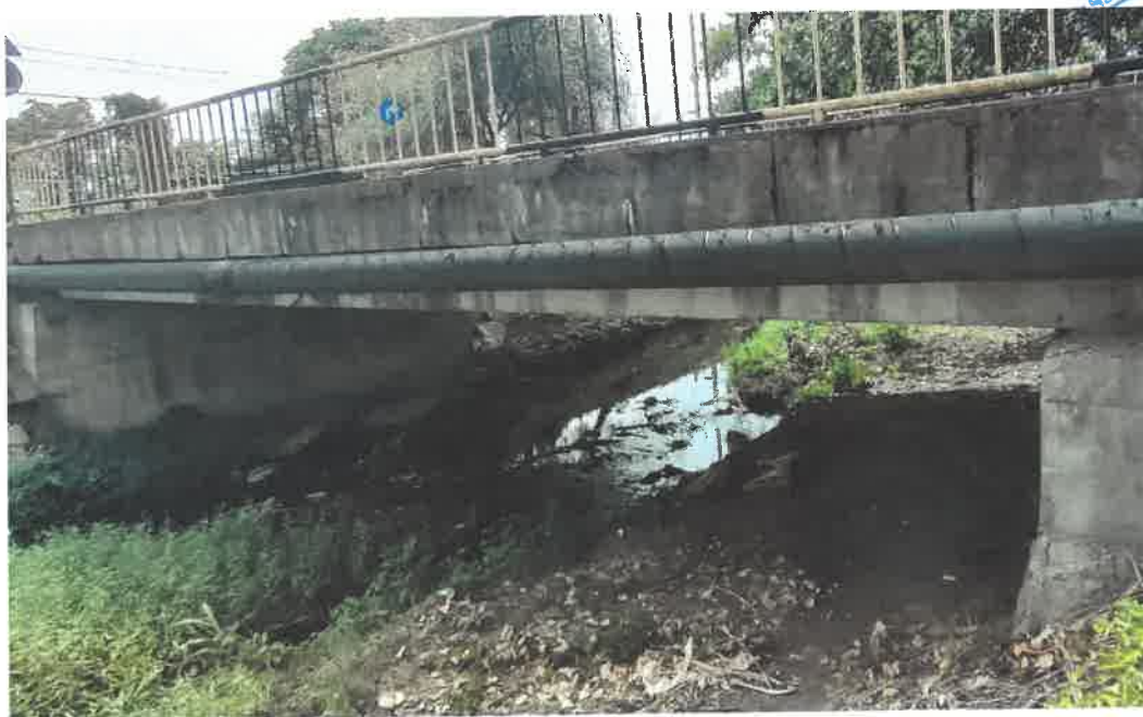
Vedere albie sub pod
