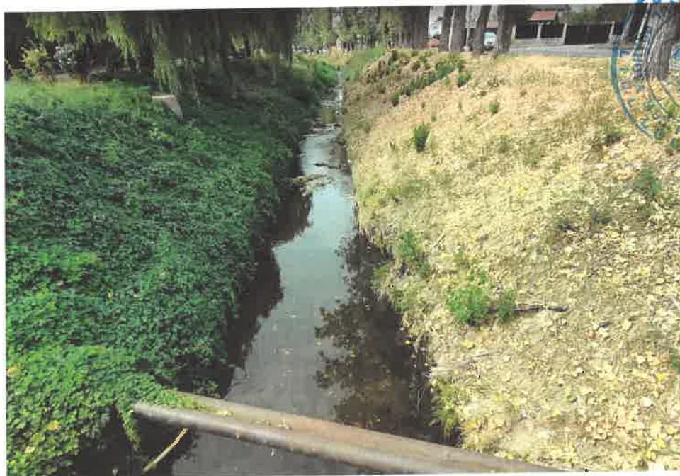
Vedere albie in amonte
