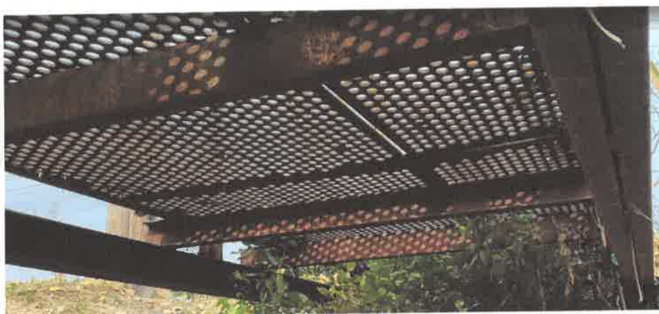
Foto 11, 12: Vedere elemente de rezistentă ce susțin calea – elemente metalice, anetretoaze
