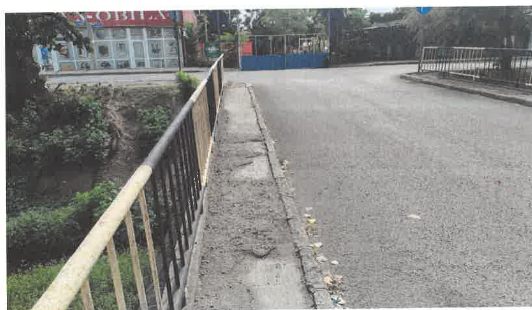
Foto 18: Vedere trotuar aval
