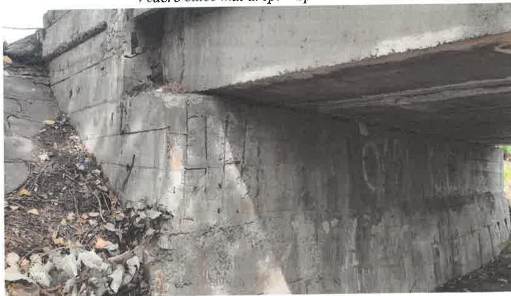
Vedere culee mal stang – Spre strada Apelor
