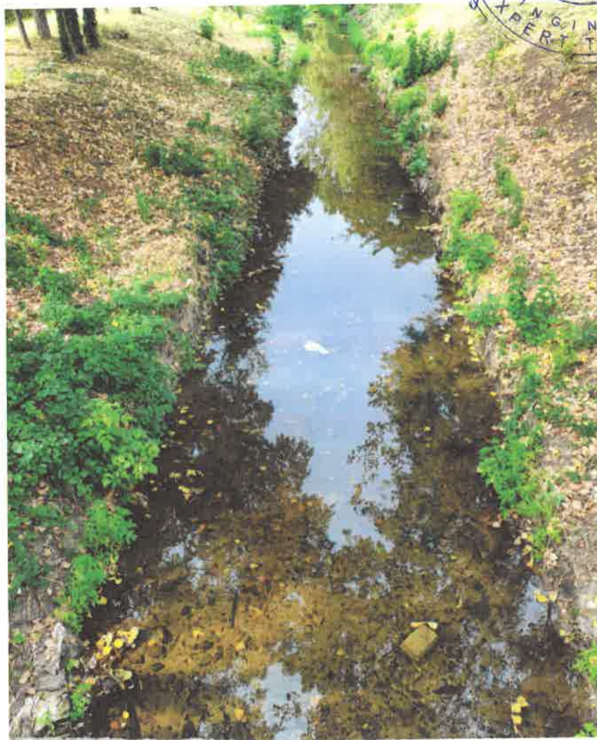
Vedere albie in amonte
