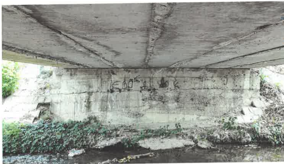
Vedere culee mal drept – Spre strada Cornatel
