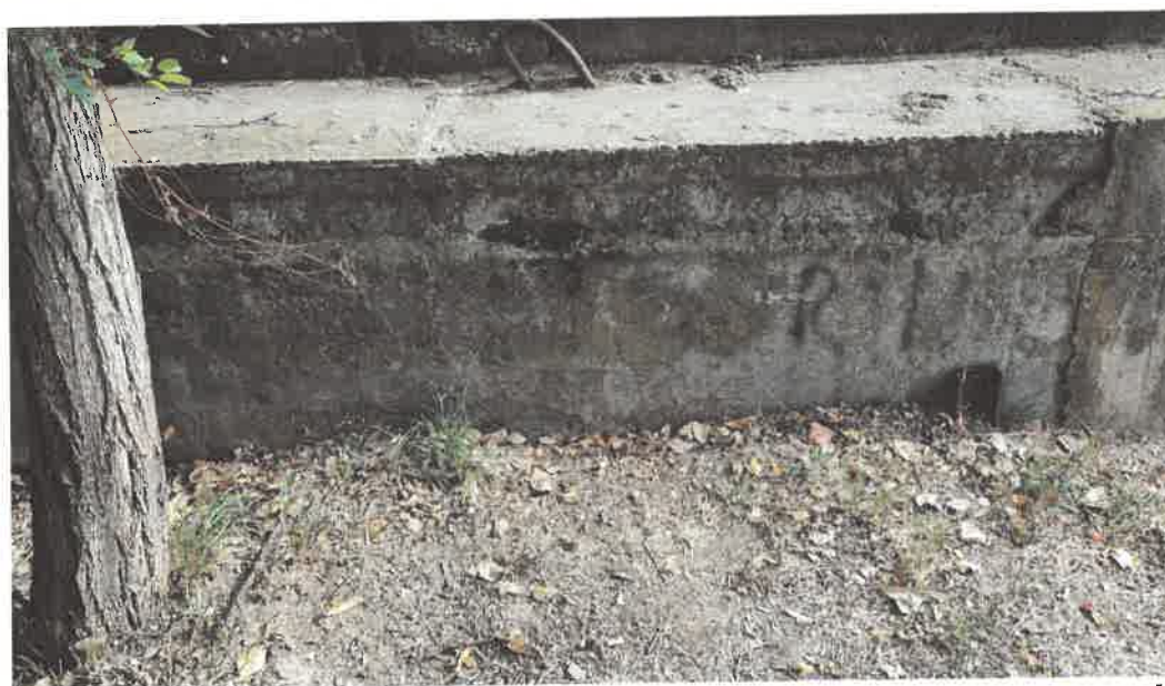
Foto 9, 10, 11, 12: Vedere suprastructura – Fascii cu goluri utilizate la sustinerea conductelor
