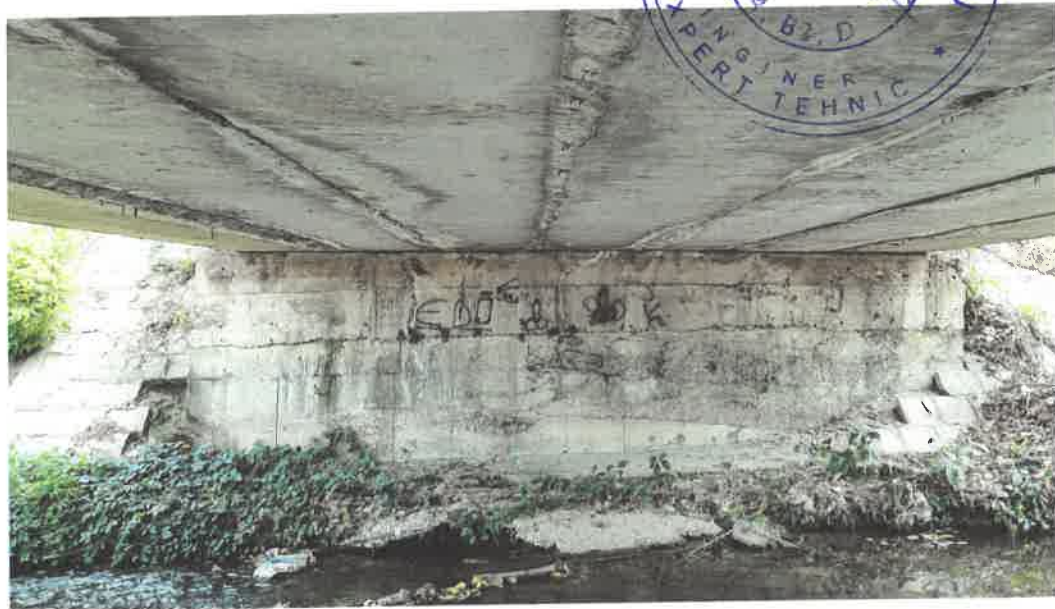
Vedere culee mal drept – Spre strada Cornatel
