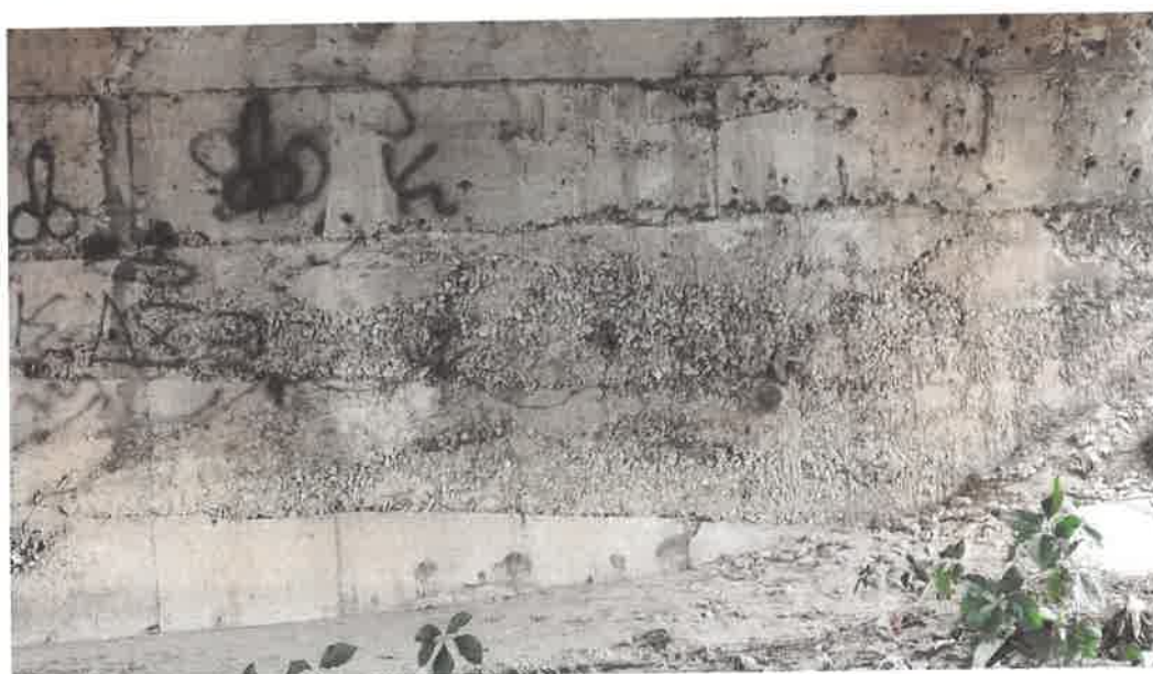
Foto 7,8,9: Degradari culee
