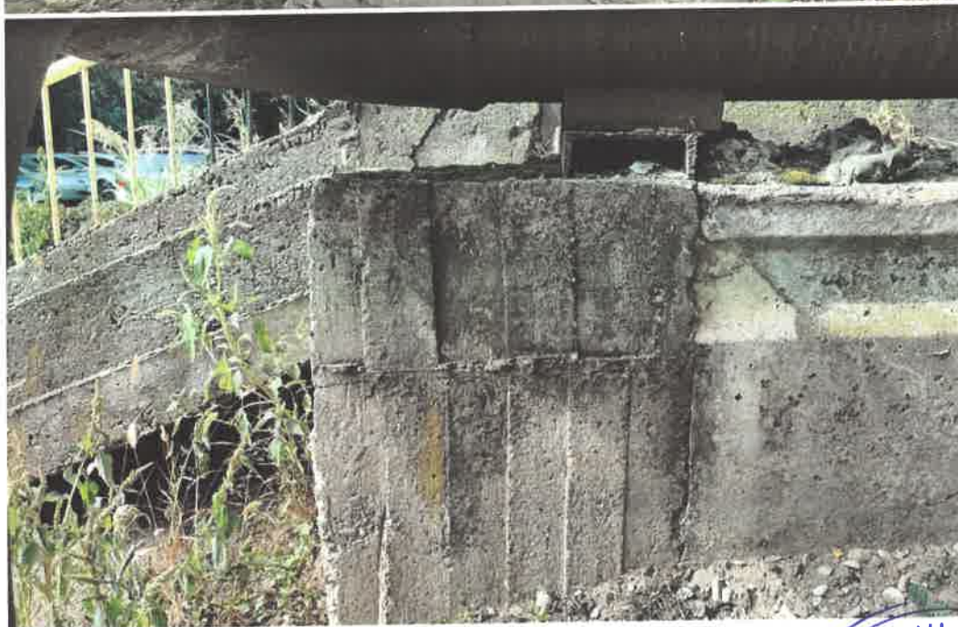
Suprastructura reazama direct pe infrastructuri prin intermediul unui strat de mortar
