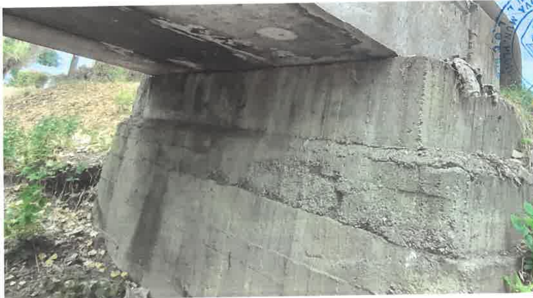
Vedere culee mal stang
