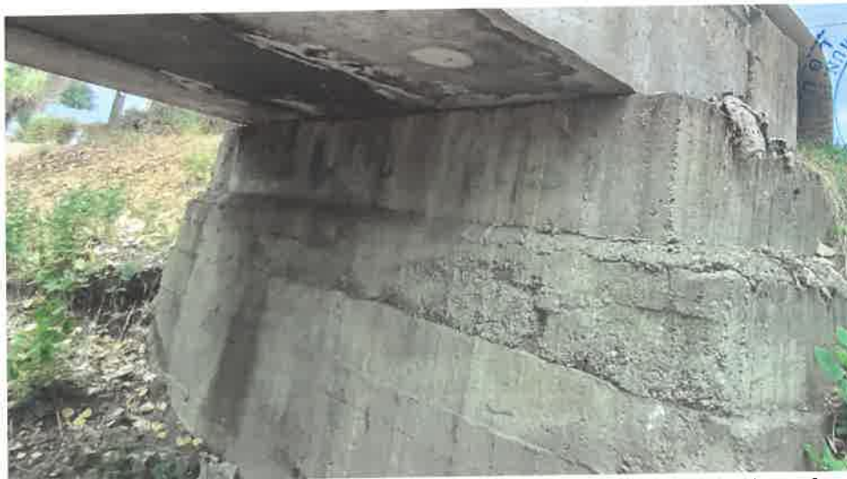
Foto 4: Vedere culee dinspre str. Apelor, racordare cu terasamentele mal stang
