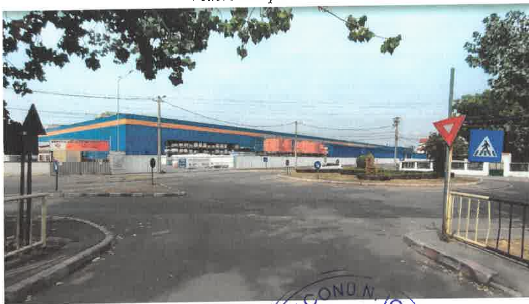
Vedere Rampa Strada Oborului/Apelor
