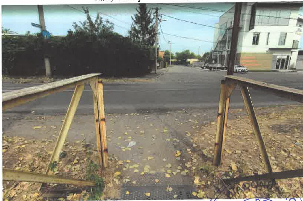
Rampa dinspre strada Apelor
