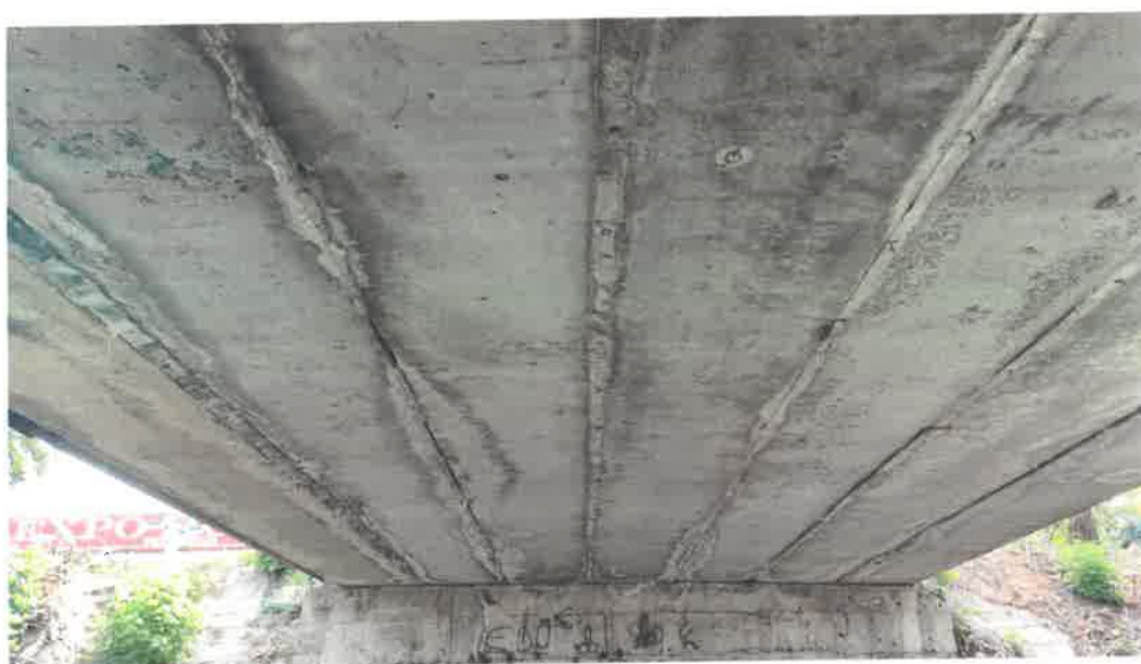
Foto 11: Vedere intrados suprastructura
