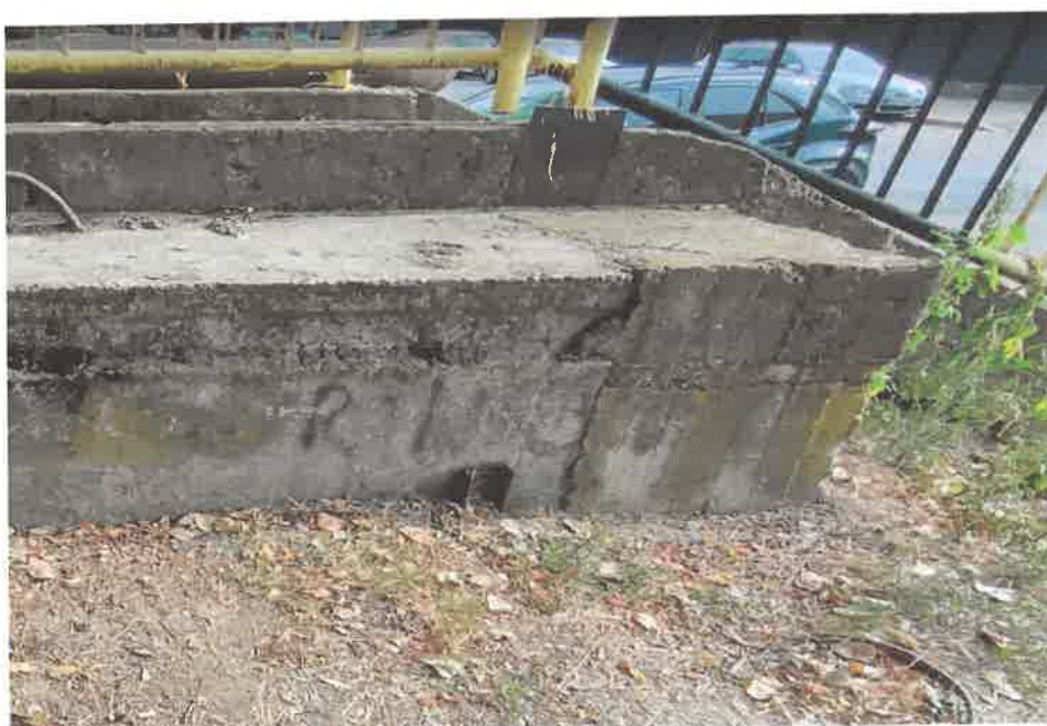
Foto 13, 14, 15: Vedere elemente de rezistență ce susțin calea – Placă de suprabetonare, anetretoaze
