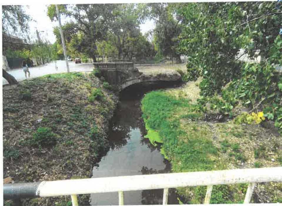
Vedere albie in amonte
