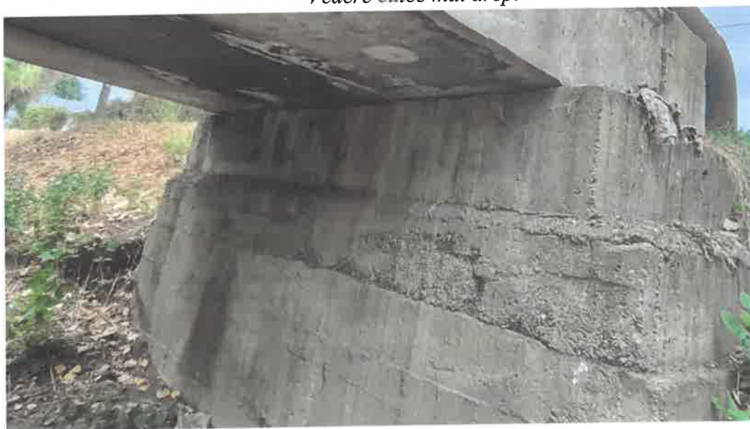
Vedere culee mal stang
