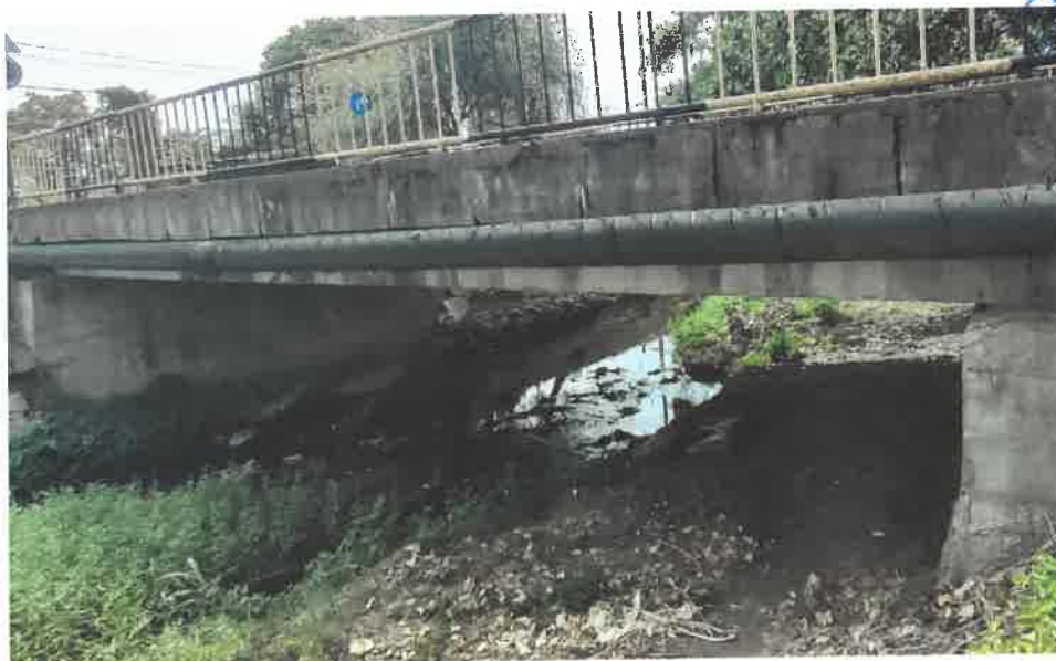
Vedere albie sub pod
