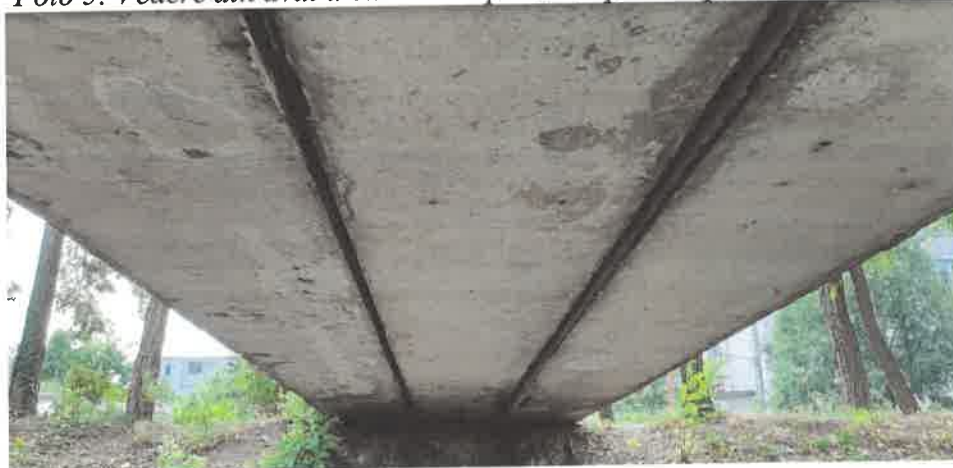
Foto 5: Vedere din aval a culeei dinspre str. Apelor, opritori antiseismici
