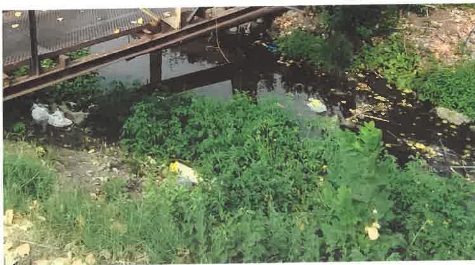
Foto 19: Vedere albie sub pasarela, depuneri, vegetatie
