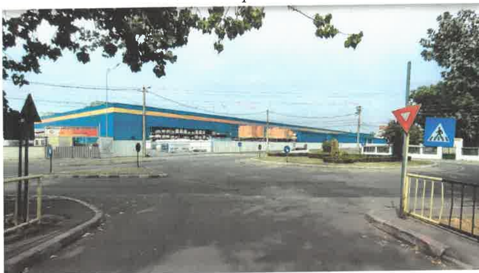
Vedere Rampa Strada Oborului/Apelor
