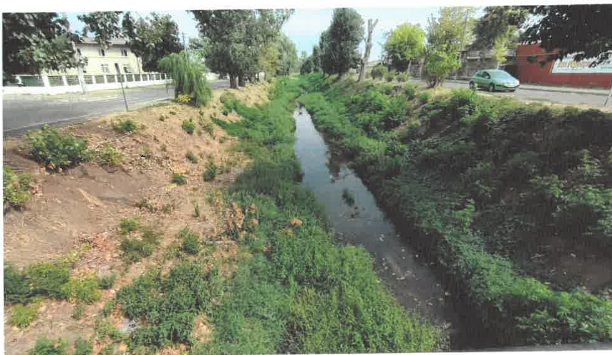
Foto 27: Vedere albie in aval, depuneri, vegetatie
