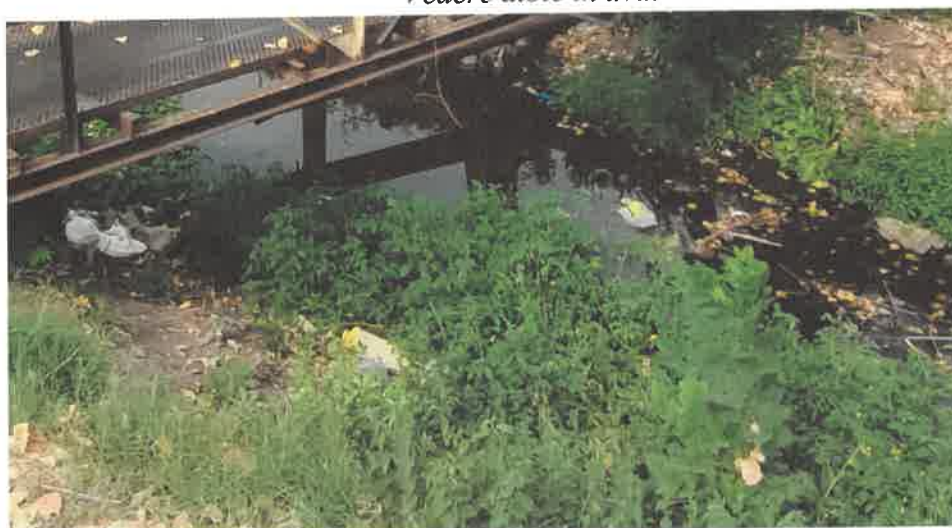
Vedere albie sub pasarela
