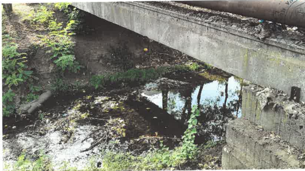
Vedere albie sub pasarela
