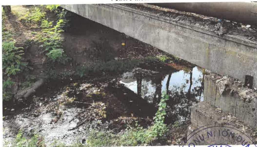
Vedere albie sub pasarela
