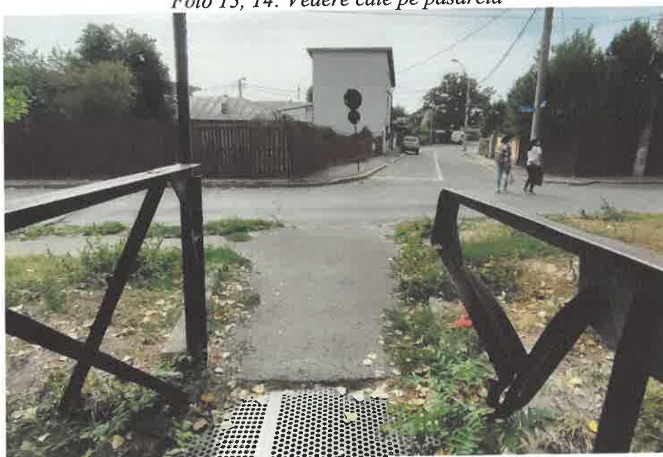
Foto 15: Vedere Rampa dinspre strada Cornatel
