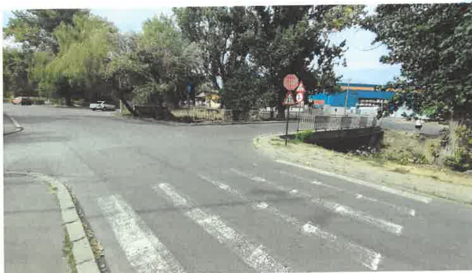
Vedere Rampa Strada Cornatel
