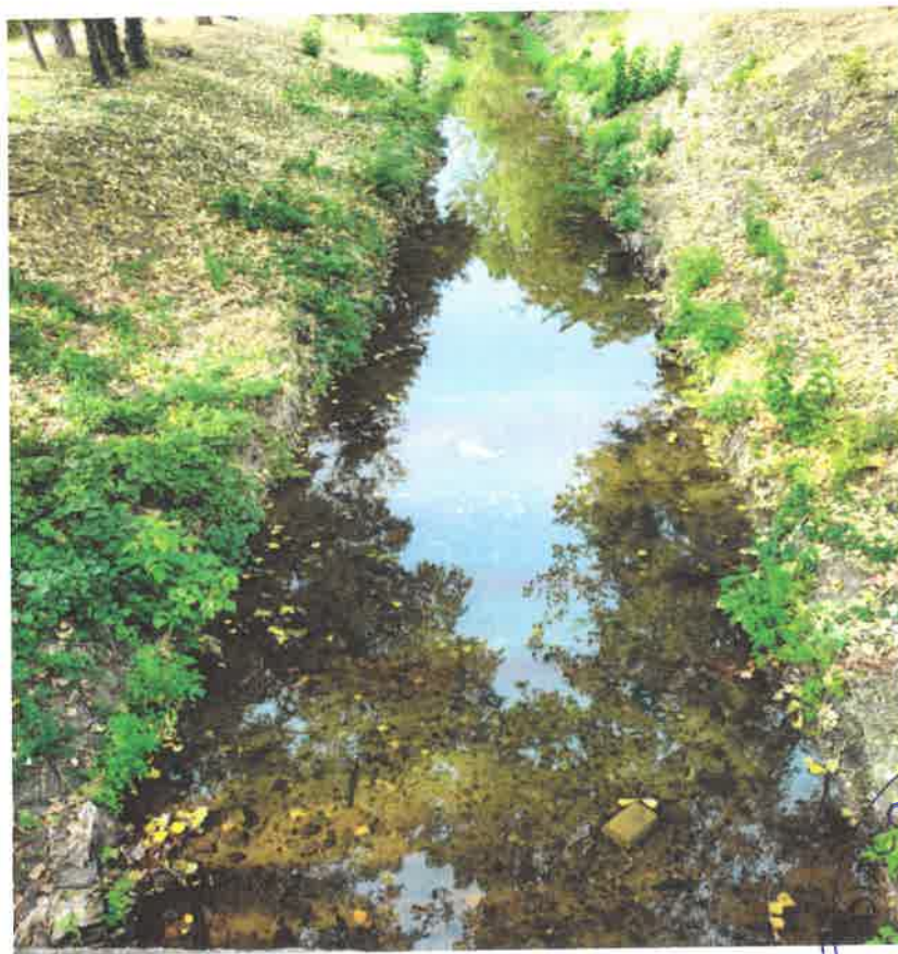
Vedere albie in amonte
