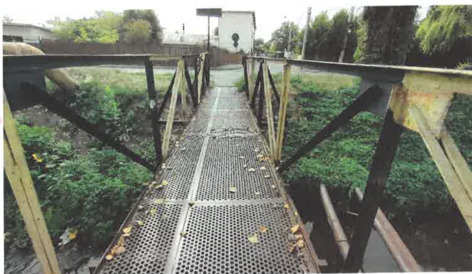
Foto 13, 14: Vedere cale pe pasarela
