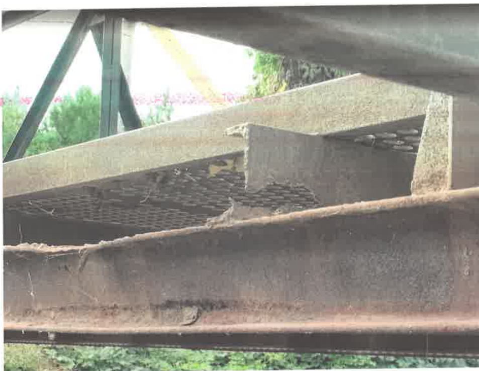
Foto 6, 7, 8, 9, 10: Vedere suprastructura degradata
