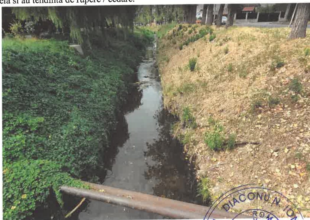
Vedere albie in amonte
