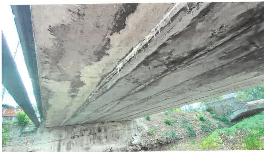
Foto 10: Vedere intrados suprastructura - Stalactite
