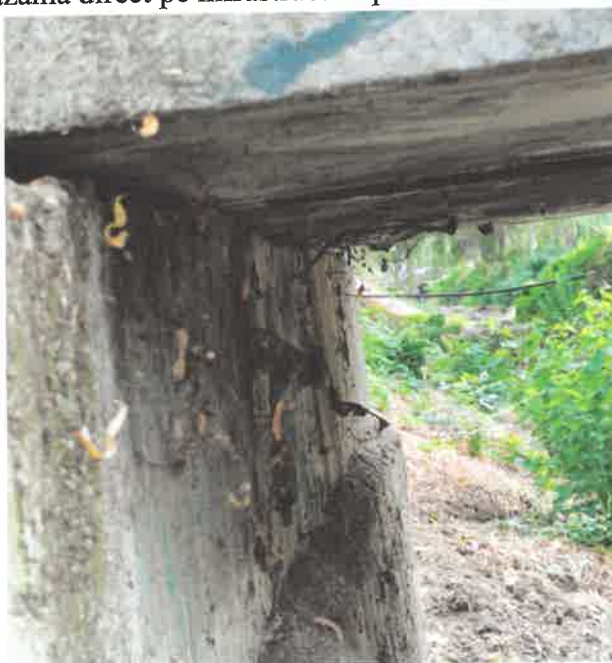
Suprastructura reazama direct pe infrastructuri prin intermediul unui strat de mortar
