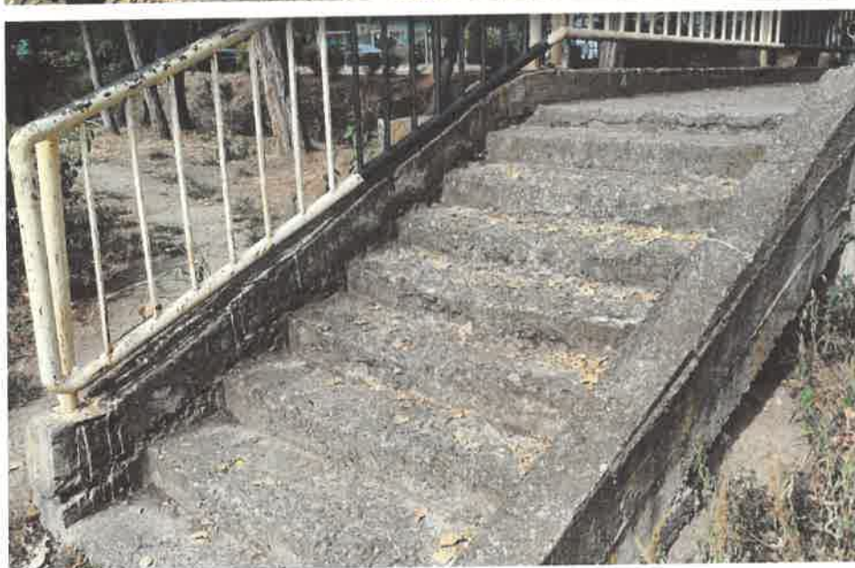
Foto 20, 21: Vedere rampa dinspre Strada Cornatel
