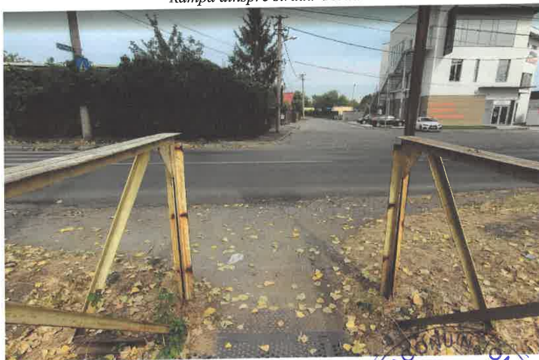
Rampa dinspre strada Apelor
