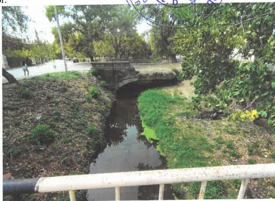
Vedere albie in amonte
