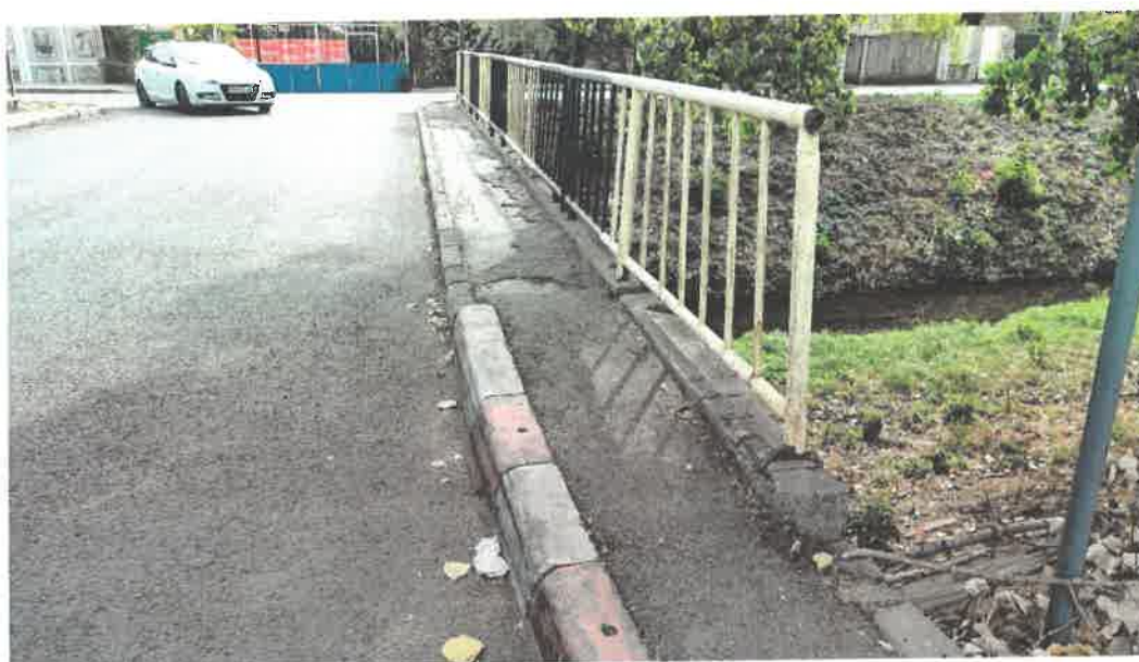
Foto 17: Vedere trotuar amonte
