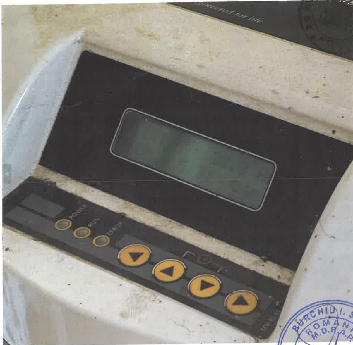
Foto 9 Display-ul pompei LOWARA arată funcționarea acesteia și după ce toate electrovanele au fost închise.
