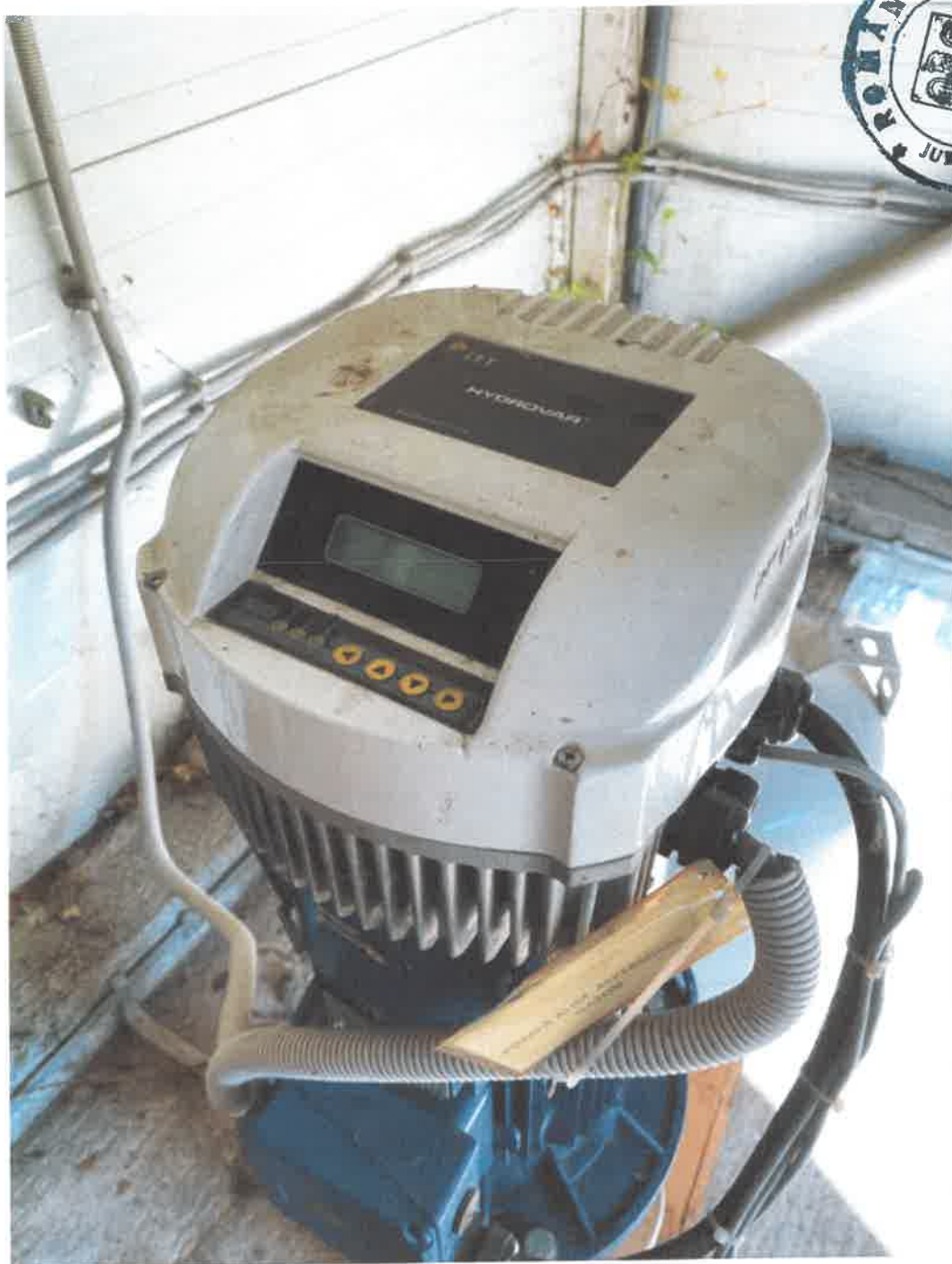
Foto 2 Tabloul de comandă și control al pompei LOWARA, cu display pentru principalii parametri de funcționare ai pompei.
