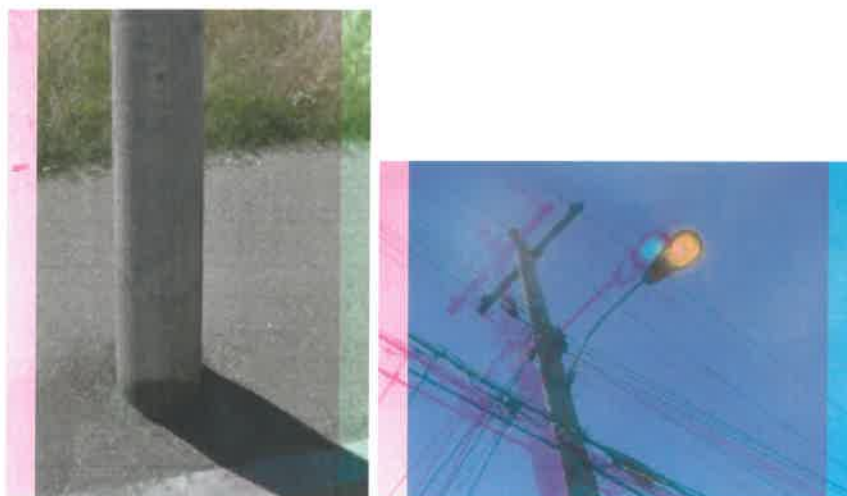
Figura2– Stalpi existenți din beton
