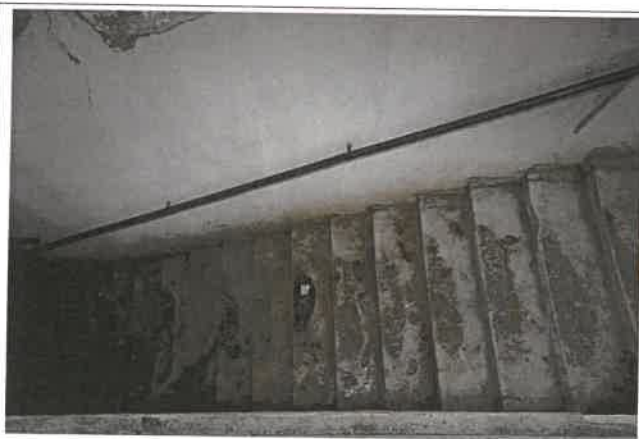
Scările de acces la construcția subterană
