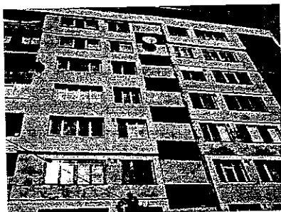
Vedere bloc 47 vedere(spate)
