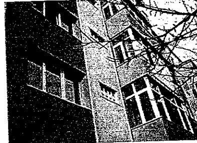
Vedere bloc nr.110 vedere(fata)
