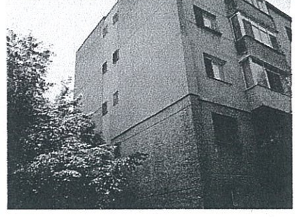
Vedere exterioara bloc 114(lateral) str. Cameliei, nr. 24
