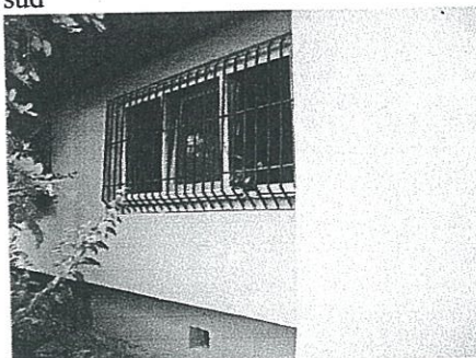
Teren =4,68mp pozitie balcon :bloc 35I2, parter ap .2 -vedere spre latura sud
