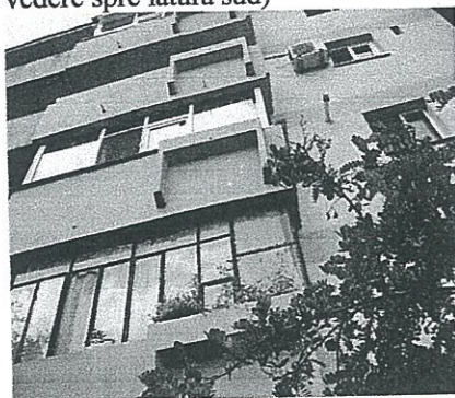
Vedere exteriora bloc 35I2 (lateral-vedere spre latura sud)
