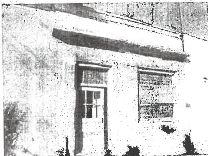
Figura 1. - vedere dinspre strada
