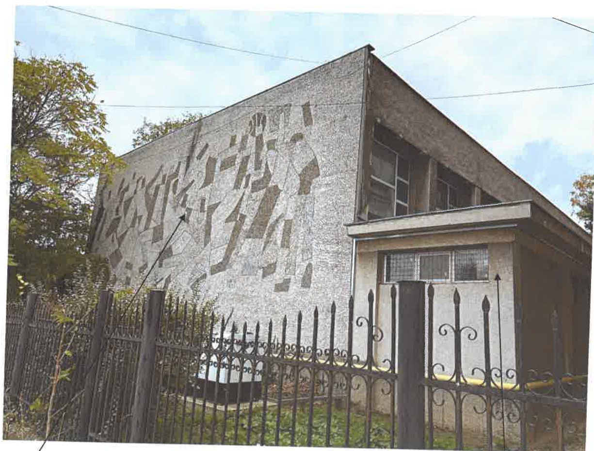
Fațadă Nord corp C4 – Sală de sport
