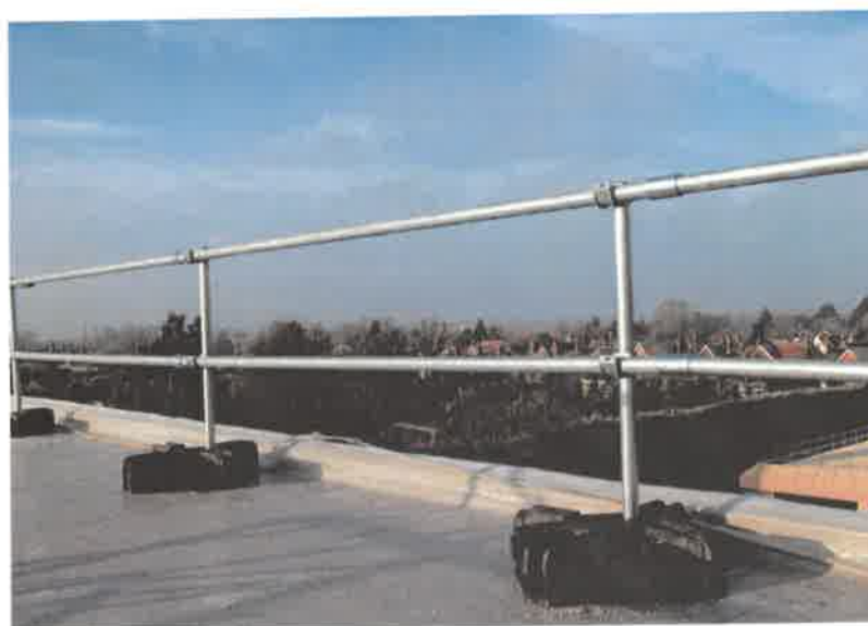
Imagine balustrada de protectie terasa necirculabila
