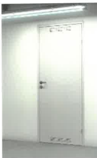
Fig. 7. Usa metalica cu foaie plina, montata la interior pe caile de evacuare
